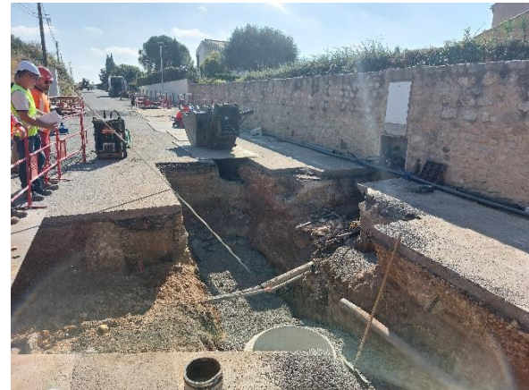
Travaux sur la commune d'Aspiran
