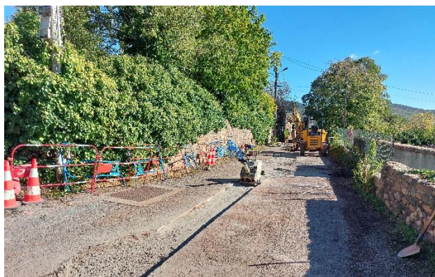
Travaux sur la commune d'Octon
